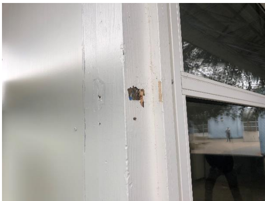
Ved indgangspartier, der er skiftet
