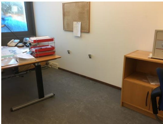
Her føres fremtidig ventilationskanal i kasse
