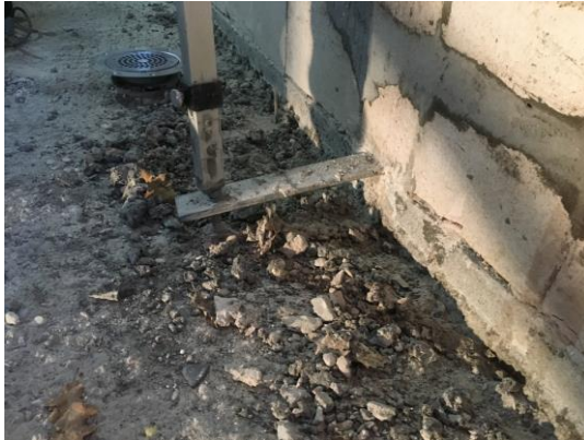
Ydervæg – Ytongblok på fundament
