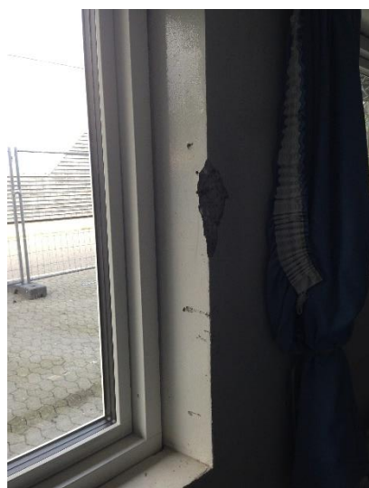
Ydervæg blok 10, Stuen
