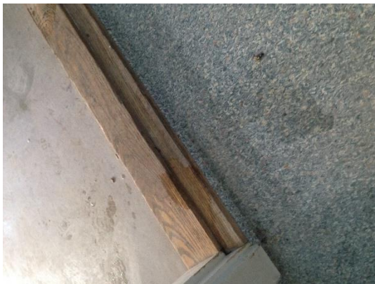
Blok 11, stueetage – rum til højre toilet
