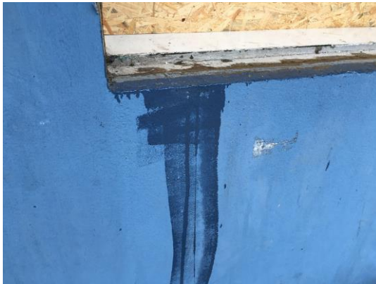
Forsegling på facade
