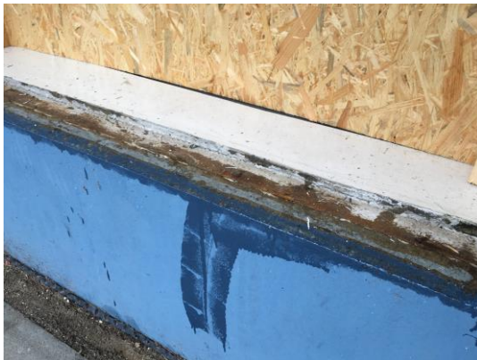
Forsegling på facade
