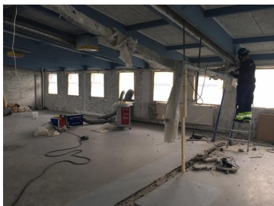
Blok 10 – 1. sal – nedrevet væg
