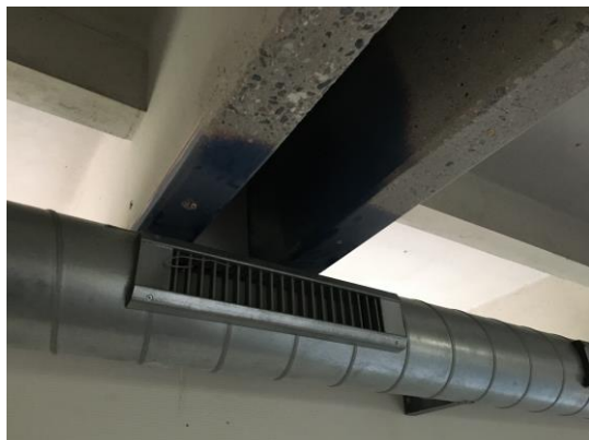
Rester af maling på betondragere
