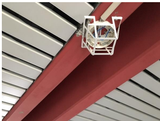
Foto af lofter og installationer stueetage
